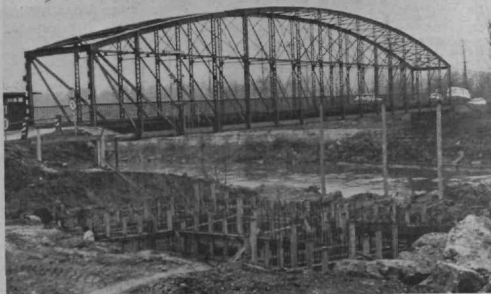
STARO IN NOVO - V Ljubljani trenutno gradijo tri mostove. Eden izmed njih je tudi Šentjakovski, ki bo nadomestil starega, ki že dolgo ne ustreza več. Odsluženi most je preozek pa tudi nosilnost ni primerna za današnji promet. Novega gradijo že nekaj časa, na zunaj pa so vidni le sivi betonski nosilci, ki dajejo voznikom upanje na boljše čase.
