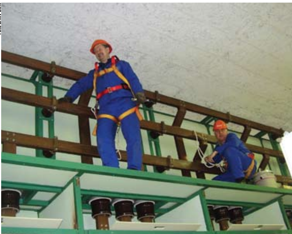
Revizijska dela na 6,3KV zbiralkah v HE Dravograd.
