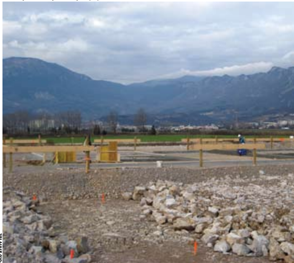
Dela na plinski kompresorski postaji Ajdovščina.
