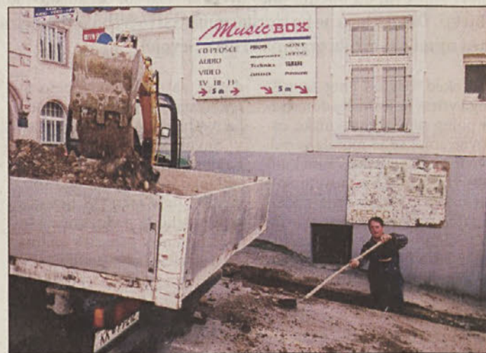
Razkopane brežiške ulice
