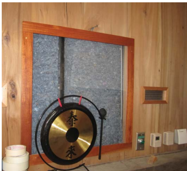
Slika 6: Prozorna obloga omogoča prikaz naravne toplotne izolacije iz recikliranega bombaža. The Willow School, ZDA, arh. Farewell Architects LLC, (Hiltner, 2013). Foto: Steve Hiltner
