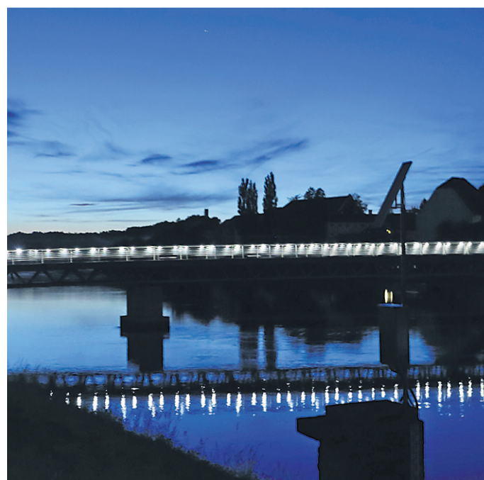
Ključni napaki pri zunanji osvetlitvi sta neprimerna vrsta svetlobe in v nebo usmerjen svetlobni tok.
