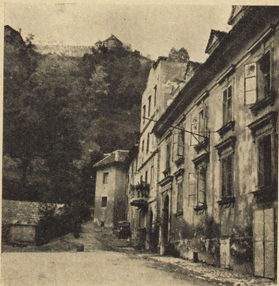
Sl. 12. Hiše na Krekovem trgu v črti nekdanjega mestnega obzidja z ostankom stolpa.
