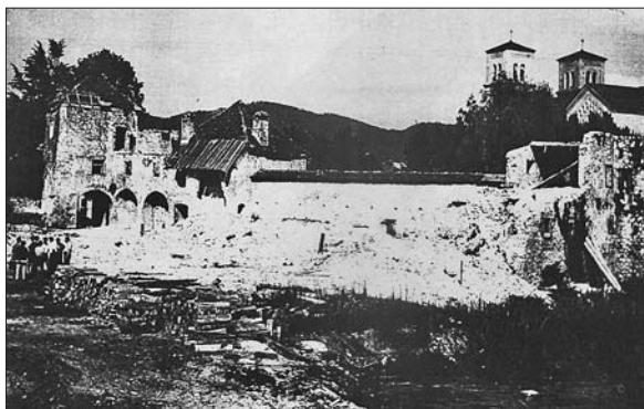
Skromni ostanki ribniškega gradu na fotografiji konservatorja Marijana Zadnikarja iz leta 1953. Na desni strani so vidne ruševine nadstropnega stranskega poslopja, ki so ga razkrili in podrli po letu 1950 (INDOK).
