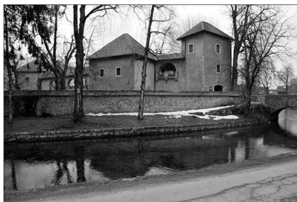
Pogled čez Bistrico na nekdanjo jugovzhodno stranico protiturskega obzidja z južnim, vzhodnim in vhodnim stolpom (foto: Igor Sapač, 2018).
