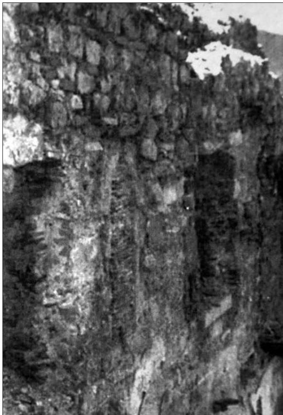
Pogled na sekundarno zazidano gotsko okno v drugem nadstropju dvoriščne fasade severozahodnega veznega trakta grajskega jedra na fotografiji Ivana Komelja iz leta 1949 (Knjižnica Mirana Jarca, Novo mesto).
