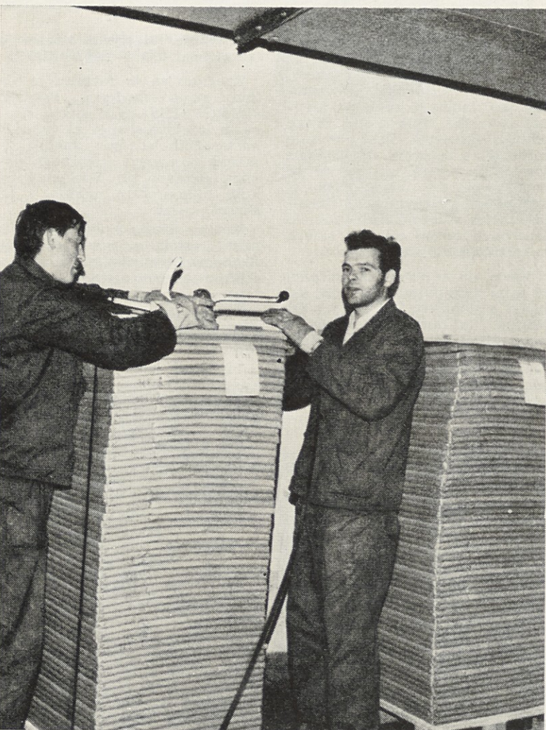
Alojz Romšek in njegov sodelavec pri vezanju papirja s tračnim železom na palete
