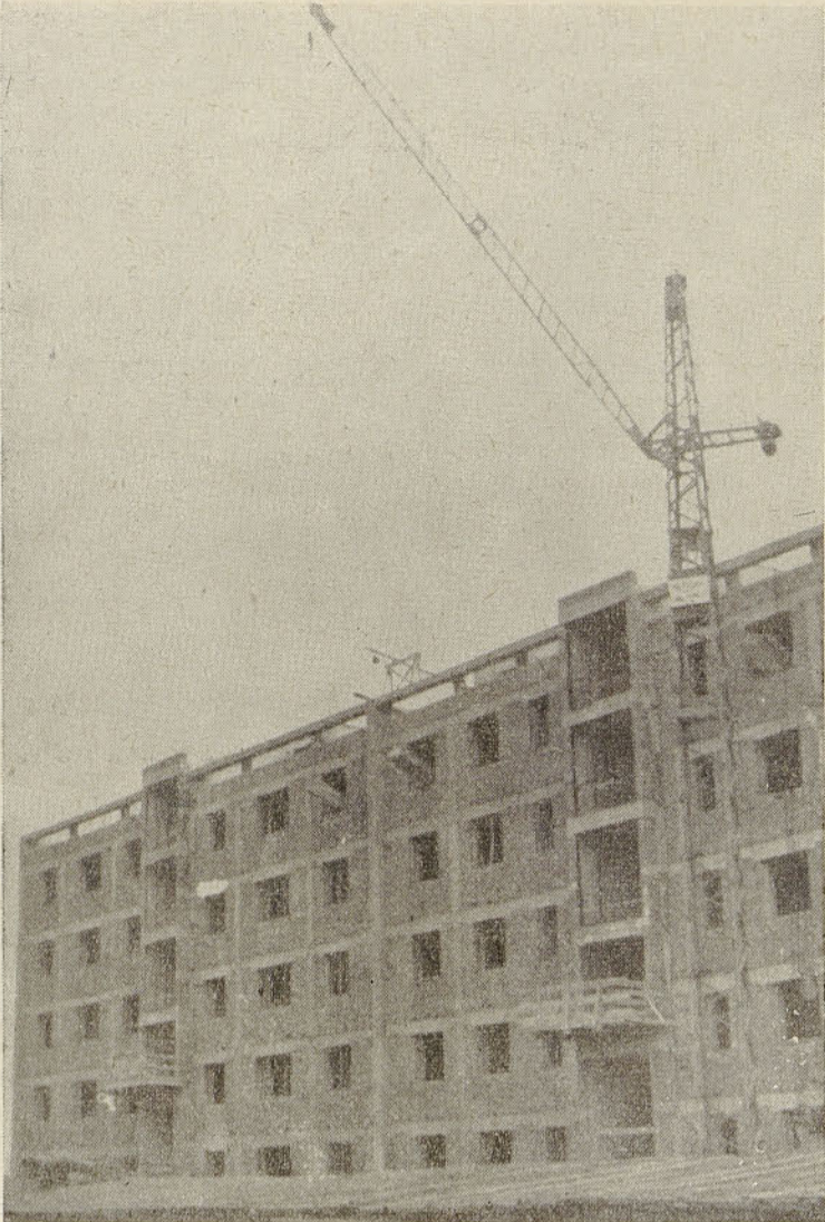
Novi 40-stanovanjski blok TGA ob Ljutomerski cesti v Ptujju med gradnjo Foto Andrej Podbreznik
