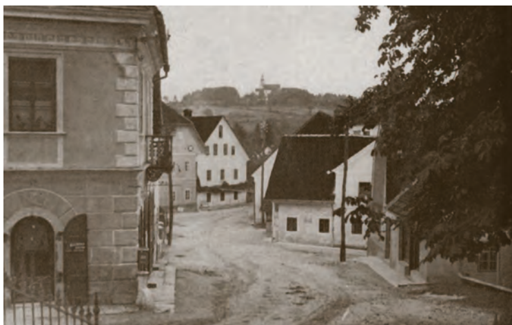
Sv. Pavla cesta, pogled izpred cerkve proti Sv. Trojici. Na levi so Kranjčeva trgovina, Bricljeva in Pečkajeva hiša ter na desni Egidijeva, Čempuhova in Tomažetova hiša (Stržinar), okoli 1930 (F. Dobrovoljc, Cankarjev album ).
