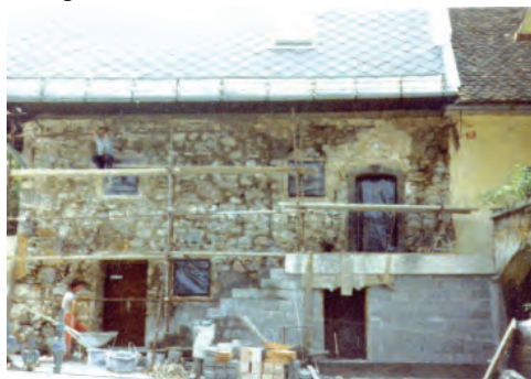
Prenavljanje Kranjčeve hiše (foto last: M. Kranjc)
