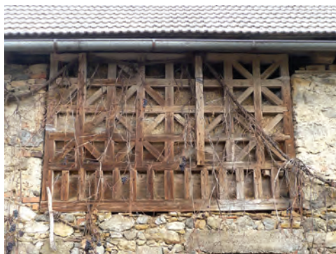
Žažar 13. Na cestno stran ima gospodarsko poslopje v nadstropju dvoje velikih prezračevalnih lin, ki sta zaprti z lesenimi mrežami, kar poslopje uvršča med največje vaše znamenitosti.
