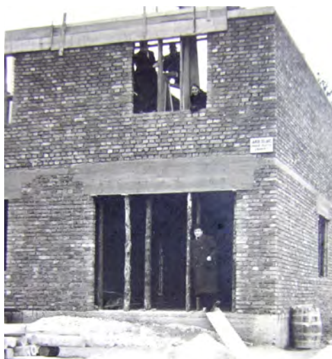
Gradnja hiše, 1941 (foto last: družina Fefer).
