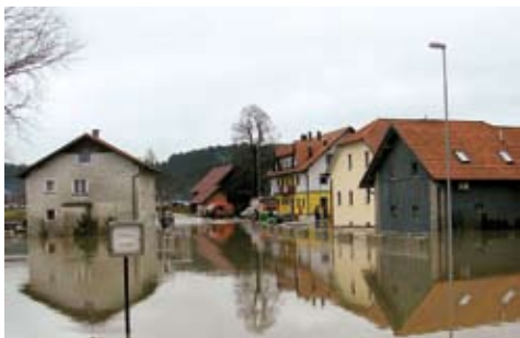
Poplavljen okrog martinjskega mostu
