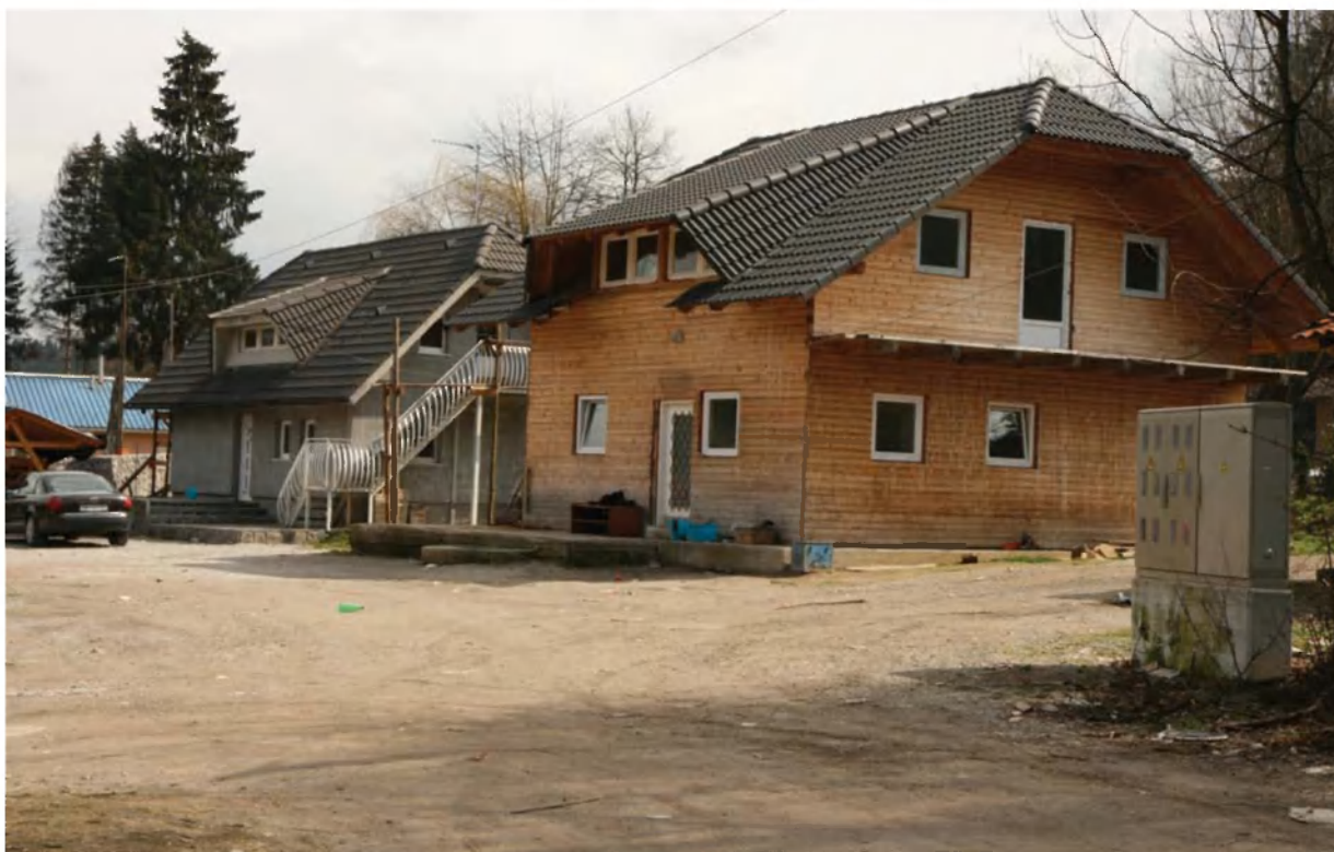
Slika 4: Novogradnje v romskih naseljih povzročajo precejšnjo prostorsko utesnjenost, kar otežuje ustrezno infrastrukturno urejanje naselij (foto: Boštjan Rogelj).
