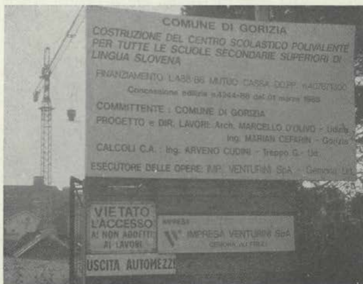
Začetek gradbenih del za novo središče gorlških slovenskih šol
