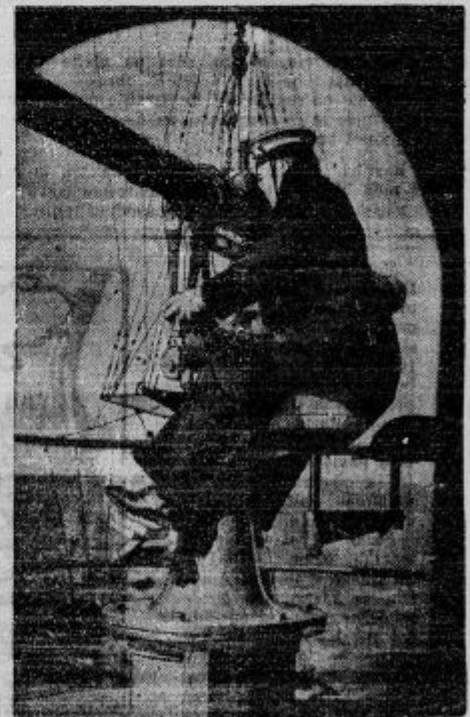
Na angleški oklopnici Rodney sledijo s pomočjo posebnega daljnogleda manevrom ostalih oklopnice. To je na vajah angleške mornarice.
