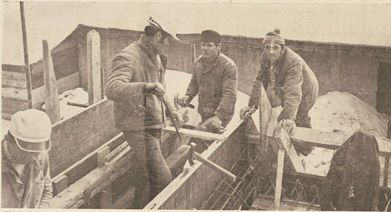
Kljub zimi in mrazu se dela na gradbiščih nemoteno nadaljujejo — Prizor iz Kranjske gore
