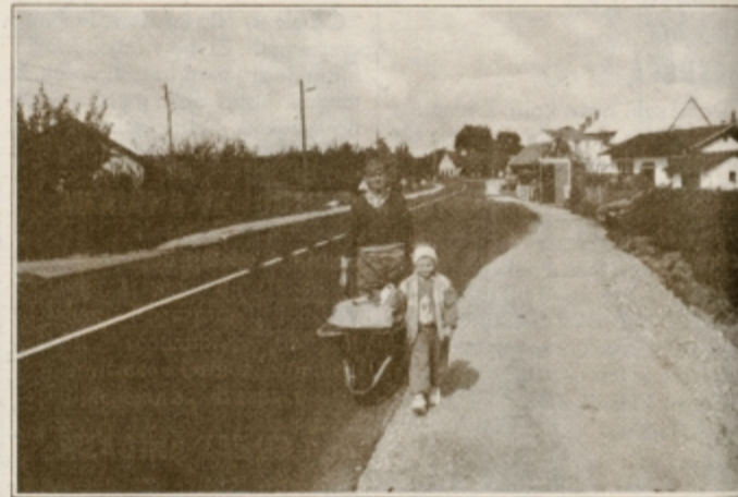
Na novo urejena cesta
