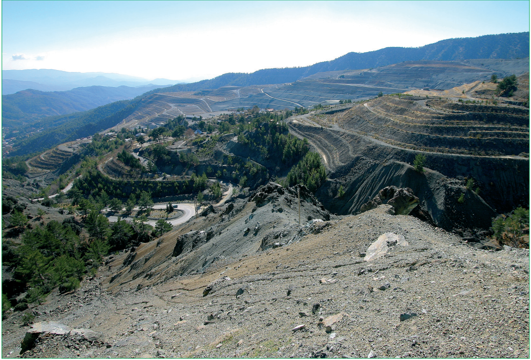
Slika 12: Začetek sanacije rudnika azbesta
