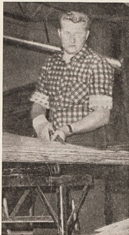
... in narejena je še ena vezana plošča
