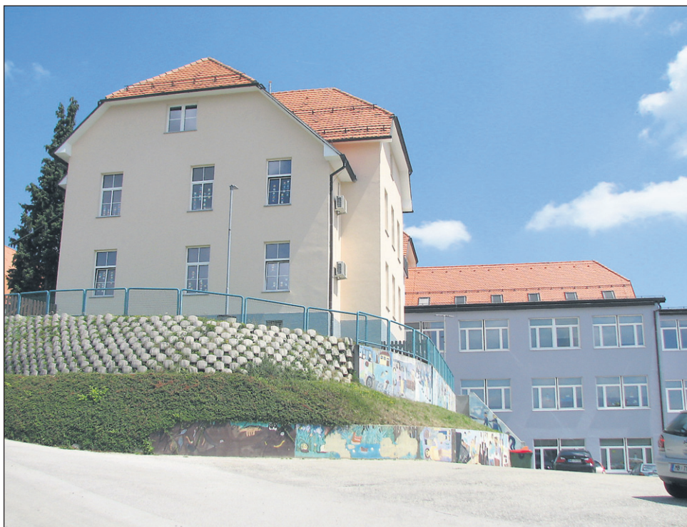
Varstvo za destrniške malčke je zaenkrat zagotovljeno v osnovni šoli (na posnetku), kjer pa ni niti ustreznih sanitarij, niti osvetlitve, niti zunanjih igralnih površin ...
