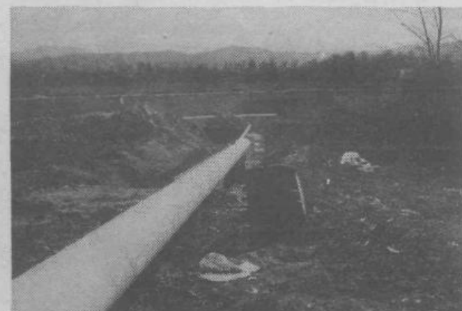
PLINOVOD — Krak velikega slovenskega plinovoda sega tudi v našo občino. Oskrboval bo s plinom nekaj tovarn. Posnetek je z Zaloške ceste, 100 m pred Poljem. (Foto: Srebrnjak)
