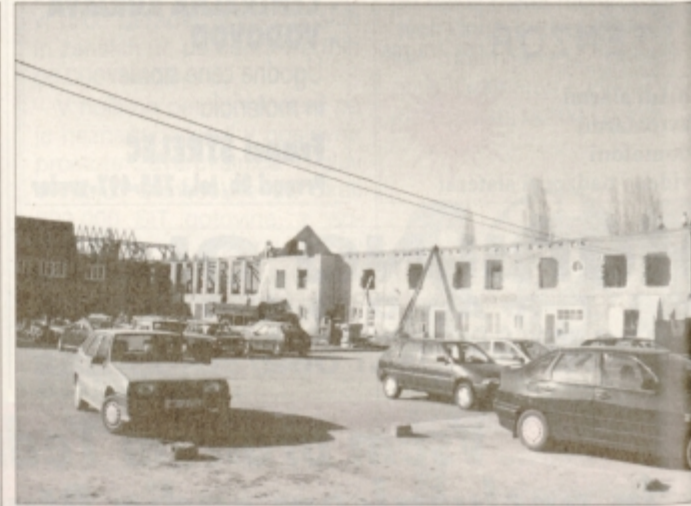
Pripravljala dela za gradnjo največjega trgovsko-poslovnega centra so se pričela. Začeli so z rušenjem objektov ob Osojnikovi 9. Posnetek je nastal prejšnji četrtek. Foto: Kosi
