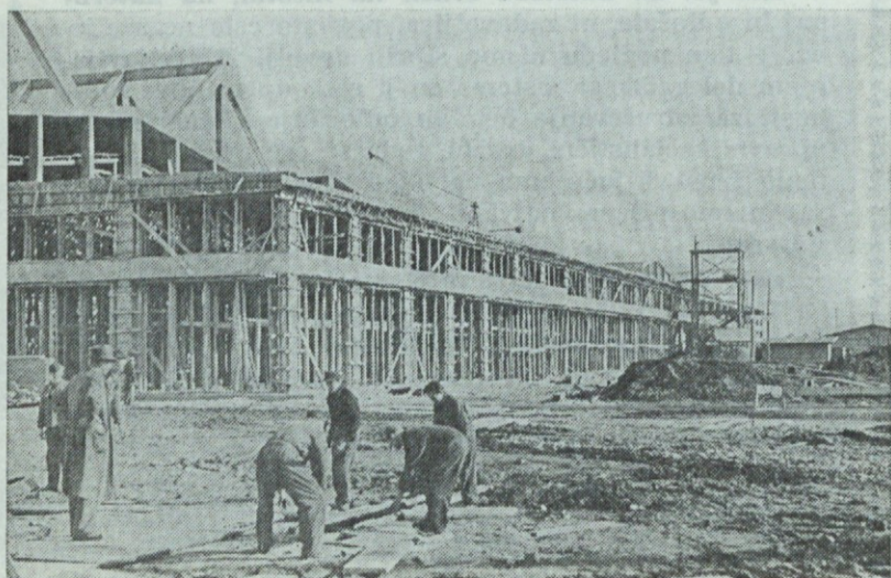
Obdelovalnica v gradnji, pogled od glavnega vhoda
