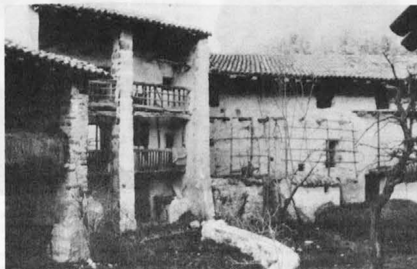
Cortile interno risanato della vecchia Breginj
