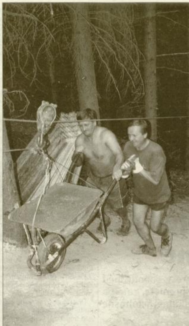
V ploščo partizanske bolnišnice so vlili 6,5 kubika »mučeniškega« betona, zadnjo samokolnico pa sta ob 18,15 v petek, 17. avgusta, pripeljala Stanko Recko in Martin Žlender.
