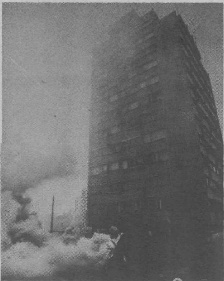
V stolpnici ob Zaloški cesti št. 76 je »po potresu izbruhnil požar«
