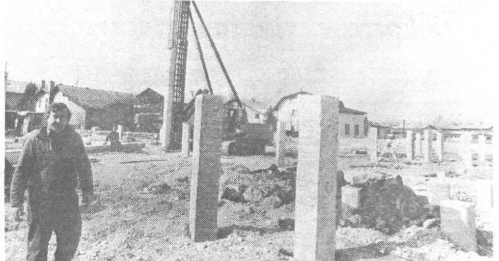
Posnetek prikazuje pilotiranje temeljev za novo osnovno šolo Livada, katere gradnja se bo pričela še v tem mesecu.
