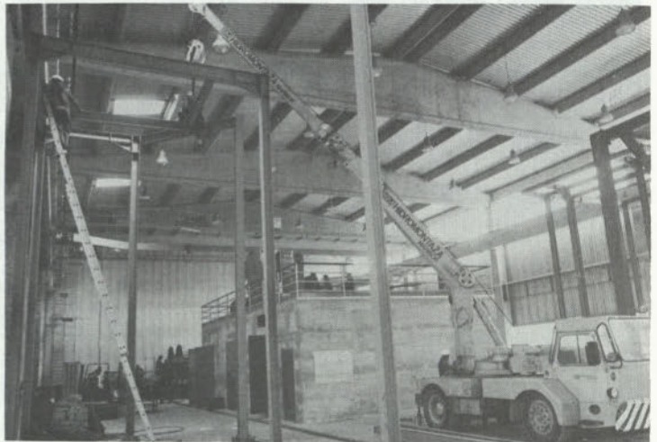
Montaža konstrukcije viseče proge
