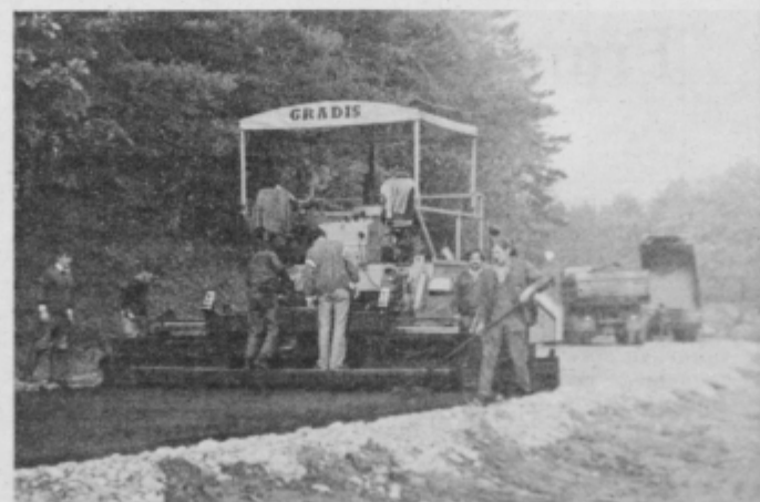
Med polaganjem asfaltne prevleke na Grabšinskem bregu.
