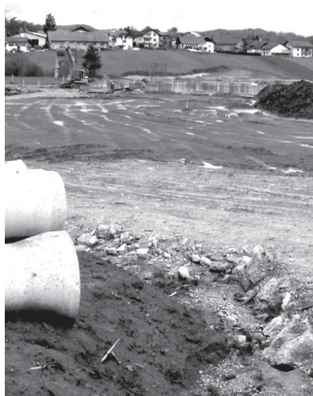
Na tem mestu bo zgrajen jez suhega zadrževalnika.
