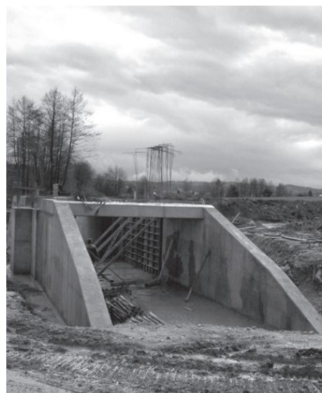
Del zgrajenega propusta na zadrževalniku Bičje, kjer bodo nameščene avtomatske zapornice.
