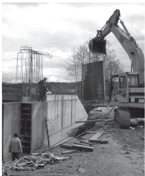
Delavci pri razopaževanju propusta v soboto, 11. aprila 2008, ko je bilo na pol deževno vreme.
