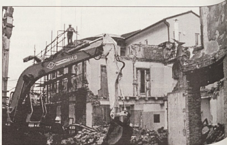
Stavba knjižnice med rušenjem. Vse, kot se da ponovno uporabiti, je že odmontirano in spravljeno.
