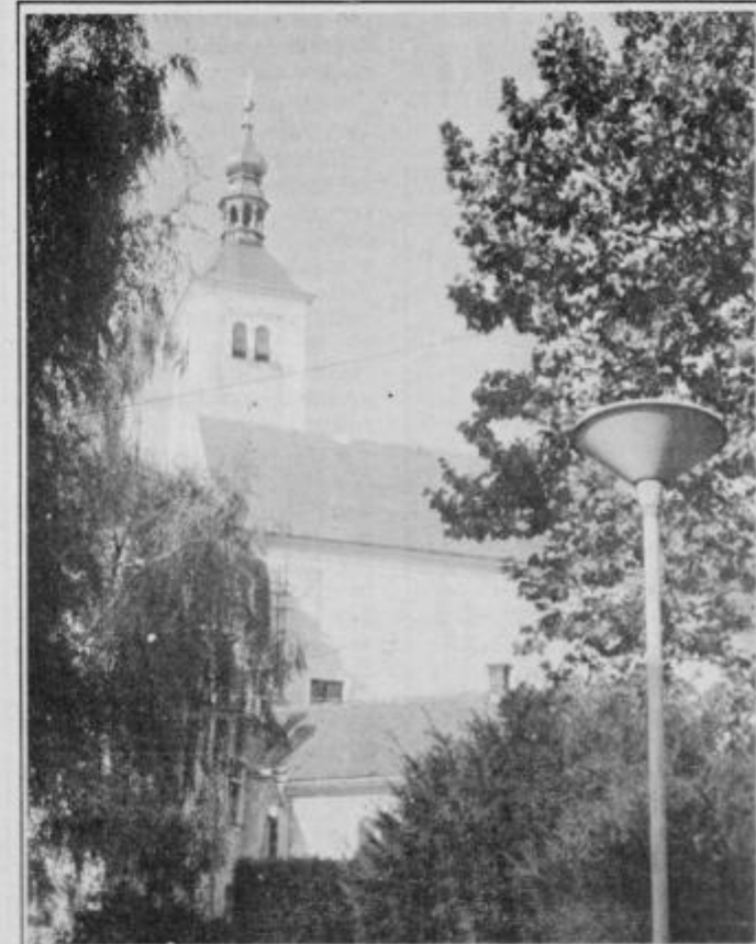
Lansko leto obnovljena streha in zvonik miklavževske cerkve. Foto: S. Hozyan
