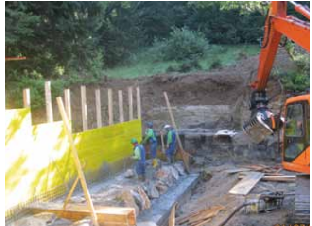
Novi zadrževalnik vode naj bi Hotenjce bolje ščitil pred poplavami. (foto: arhiv KS Hotedršica)
