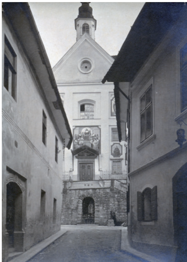
Pogled na pročelje nunske cerkve v Škofji Loki, začetek. 20. stoletja. (hrani: AUŠL)
