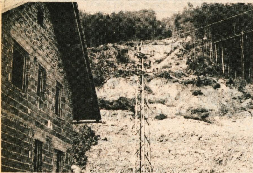
Na Blejski Dobravi so začeli odstranjevati posledice zemeljskega plaz. ki je ogrozil nekaj hiš tako, da so se prebivalci morali začasno odseliti. Cesta na Blejsko Dobravo, na katero se je zgrnil zemeljski plaz, pa še vedno ni prevozna in zato poteka promet po obvozni poti. Foto: D. S.
