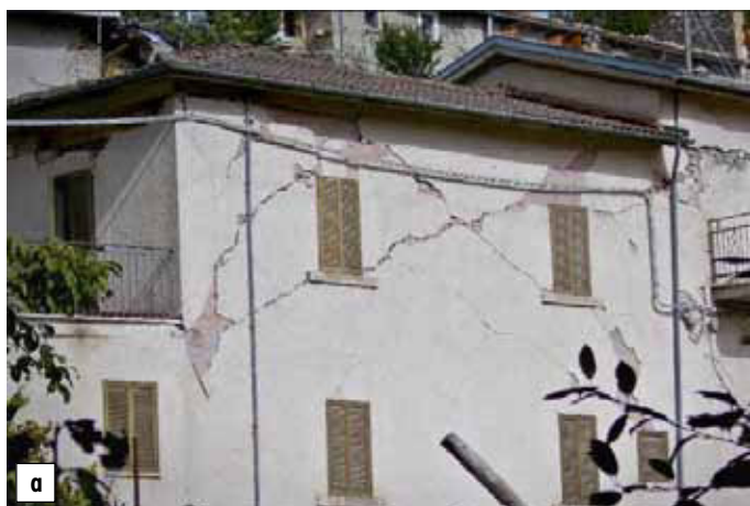
Slika 7 • Tipične diagonalne strižne razpoke v nadstropju (a) in v pritličju (b).
