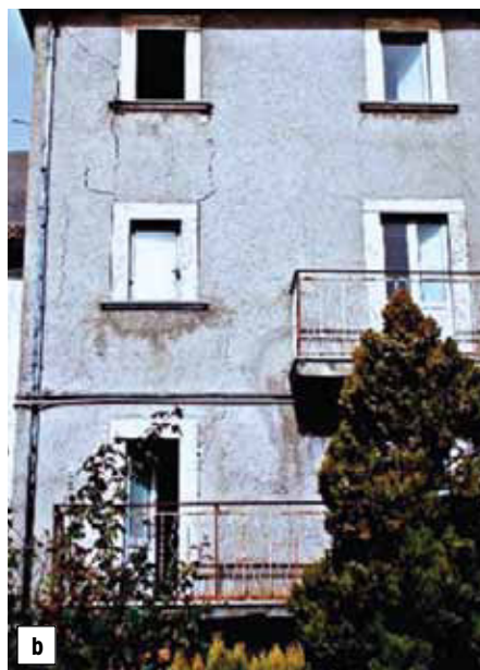
Slika 8 • Izpad zidu iz lastne ravnine (a), pojav navpičnih razpok (b) ter izguba stabilnosti in ločevanje zidov (c).
