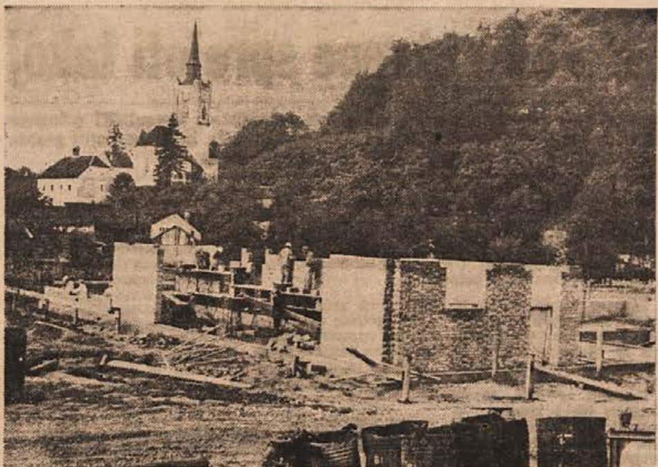
Nova šola na Mirni že raste. V prvi etapi gradnje, ki bo stala 321,5 milijona starih dinarjev, bo zgrajenih 8 učilnic, 6 kabinetov, telovadnica, knjižnica in še nekaj pomožnih prostorov, kasneje pa bo prizidanih še 7 učilnic. Za šolo bodo prebivalci občine v obliki samopriskpeva zbrali do konca tega leta 105 milijonov starih dinarjev. (Foto: Legan)
