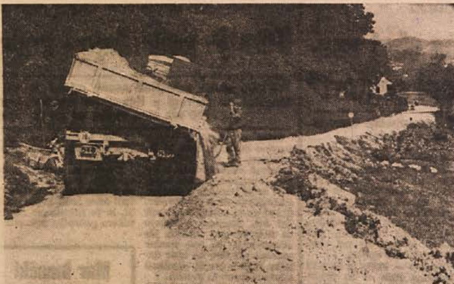
Prvi kilometer škocjanske ceste so delavci novomeškega Cestnega podjetja položili 13. in 14. septembra, če bo vse po sreči, pa bo cesta v celoti asfaltirana še v tem tednu. Dela hitro napredujejo. Preden cesto asfaltirajo, morajo napraviti dobro podlago. Na sliki: s tovornjaka stresajo material za podlago. (Foto: Polde Miklič)
