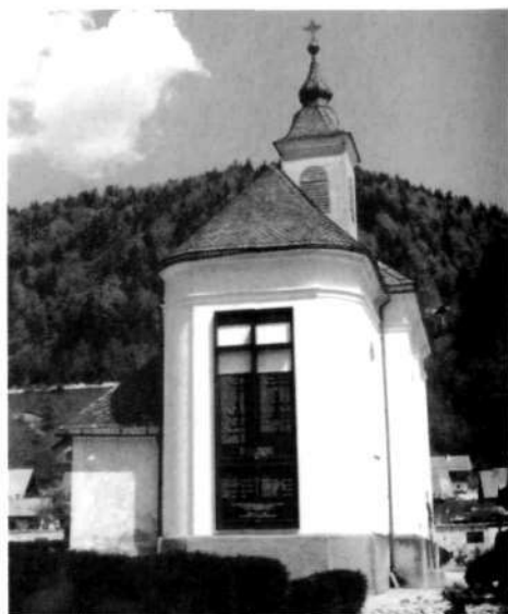
Zadnja stran pokopališke kapele v Selcih s spominsko ploščo. Streha kapele in zvonikova kapa sta pokriti s strešnimi ploščicami, najbrž zaliloškimi. (Foto Minka Bricelj)
