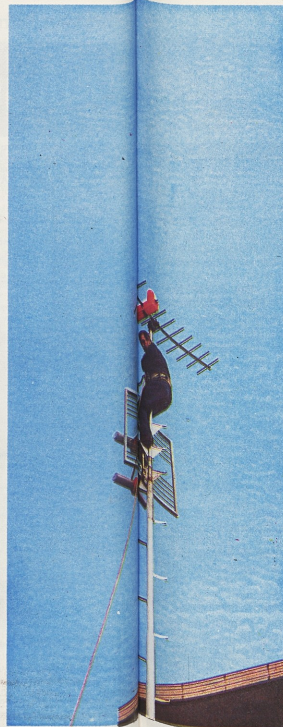
Občudujemo pogum naših monterjev: na sliki - montaža sistema oddajnih in sprejemnih anten TV pretvornika
