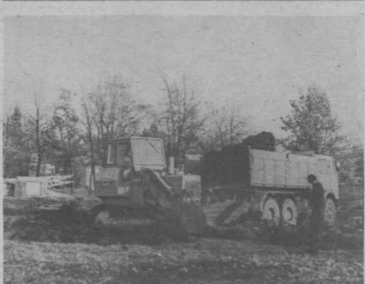
Gradnja nove šole ob Zadobrovske cesti v Novem Polju poteka po načrtu. Gradbišče je ograjeno z leseno ograjo sredi hrastovega gozdička, priključujejo pa že kanalizacijo. O poteku gradnje bomo občanom poročali v prihodnjih številkah Naše skupnosti.
