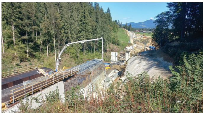
Slika 6. Pogled vzdolž gradbišča viadukta Višočnik, september 2022 (Foto: DARS, d. d.).
