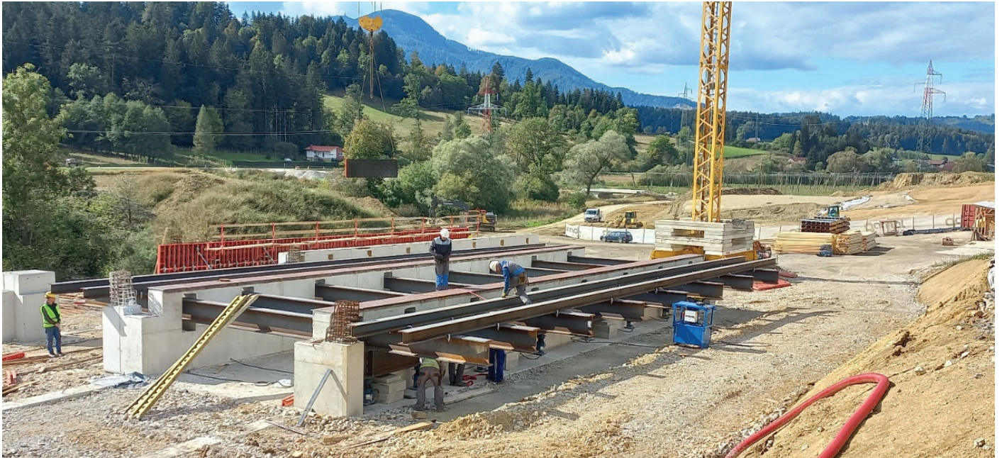
Slika 3. Dela v delavnici, narivni postaji, viadukta Jenina, september 2022 (Foto: DARS, d. d.).
