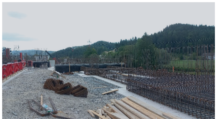
Slika 5. Armatura temelja delavnice viadukta Jenina, avgust 2022 (Foto: DARS, d. d.).
