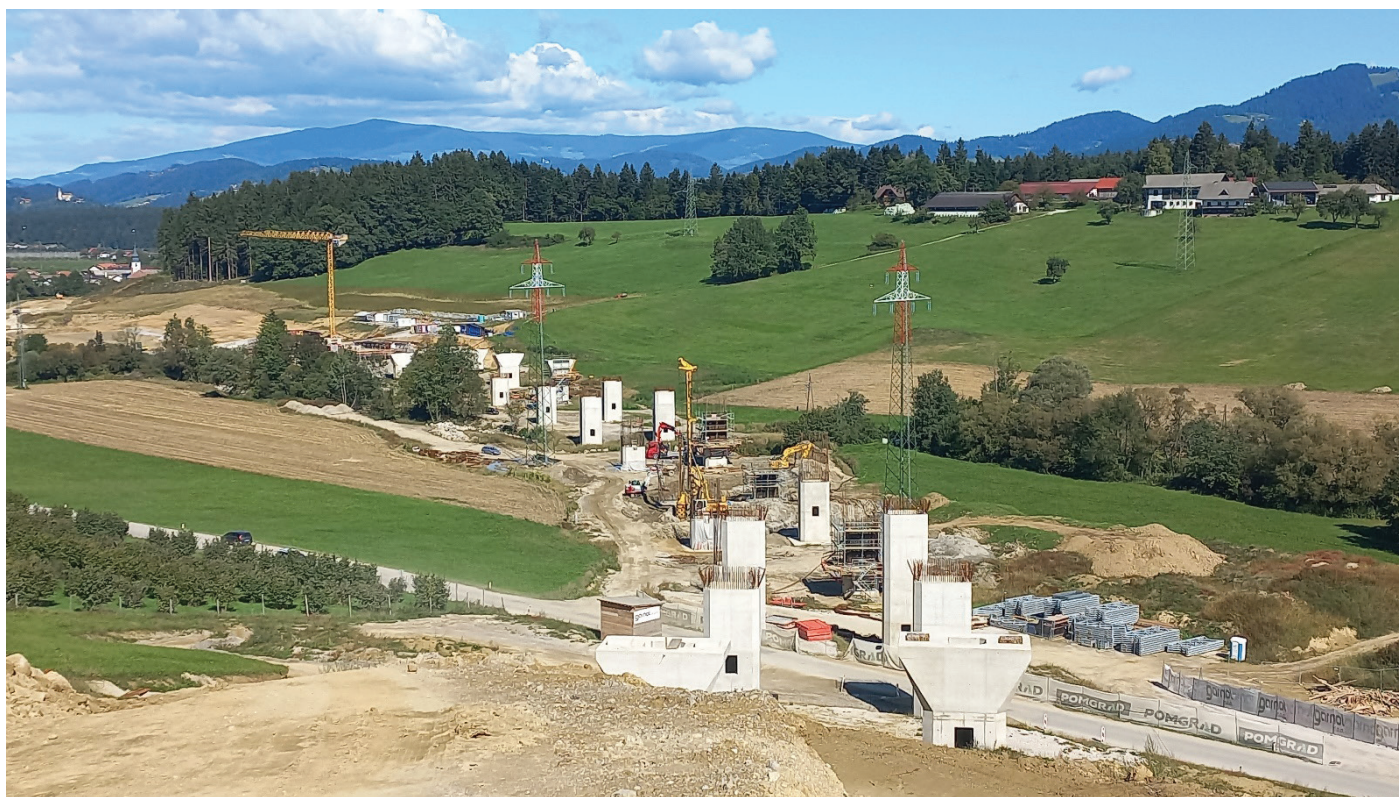
Slika 1. Pogled vzdolž gradbišča viadukta Jenina, september 2022 (Foto: DARS, d. d.).
