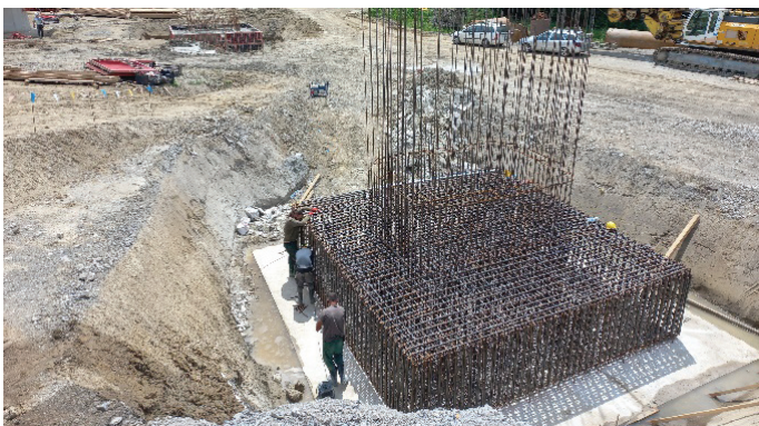
Slika 4. Armatura temeljne blazine stebra viadukta Jenina, julij 2022 (Foto: DARS, d. d.).
