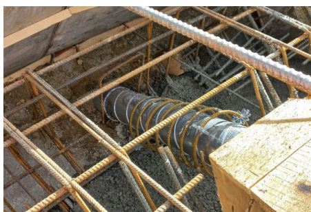
Slika 10. Detajl ojačitve grede z armaturnim železom na mestu sidrišča oporne konstrukcije 10_OK-40.
