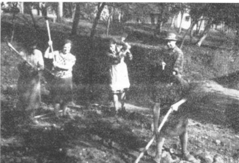
Krajevni odbori občine Lenart so letos precej postorili pri popravilu krajevnih cest in poti. Zlasti se je delo zadnji čas razmahnilo, saj to omogoča lepo sončno vreme. Na sliki: Skupina delavcev pri popravilu ceste Gradišče — Zg. Porčič.
