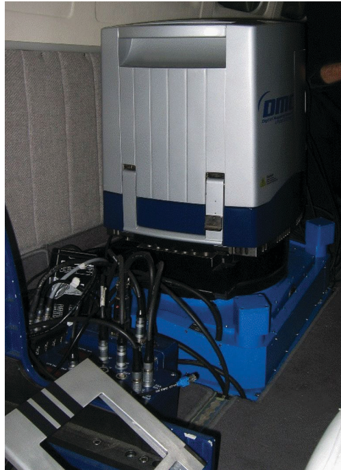
Slika 1: Digitalni aerofotoaparati velikega formata Digital Mapping Camera (DMC), ki je bil vgrajen v letalo Geodetskega zavoda Slovenije Piper PA-31-350 Navajo Chieftain (S5-CGC) (foto: Rok Valič).
