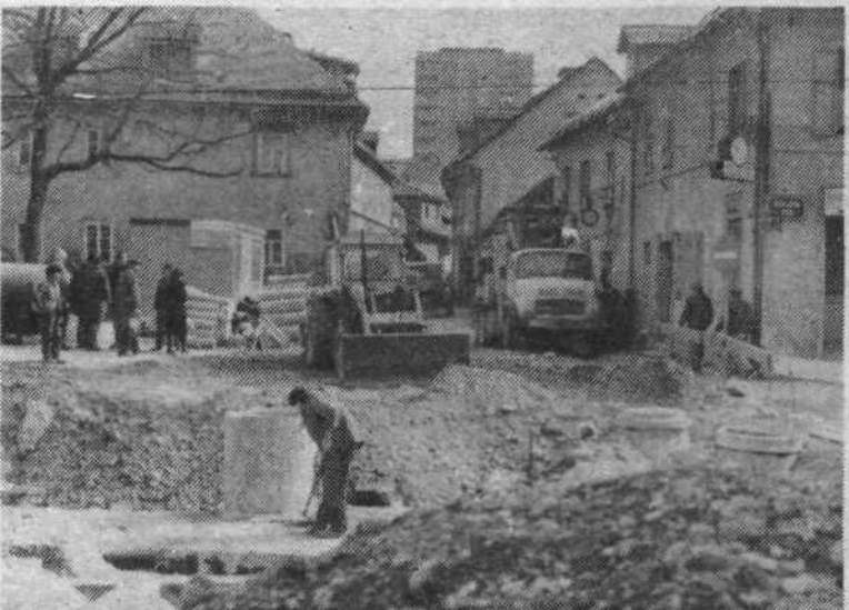
Po vesteh iz Komunalne skupnosti Ljubljana Center se bodo kmalu nadaljevala končna dela na Trubarjevi cesti – odesek Rozmanova–Rešjeva cesta.
