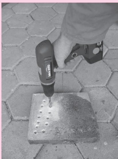
□ Slika 5. Vrtanje v beton z akumulatorskim vrtalnikom – še pred nekaj leti nepredstavljivo
