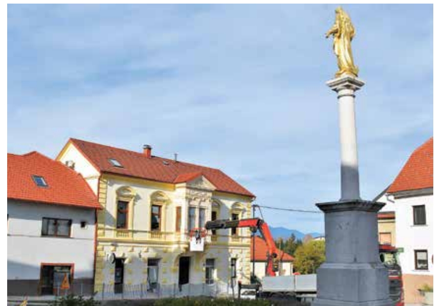
Tajnskova vila, v kateri je sedež preboldske občine, je bila znova temeljito obnovljena. Vrednost del je 42.600 evrov, delo pa je izvajalo preboldsko podjetje Laren gradnje.
