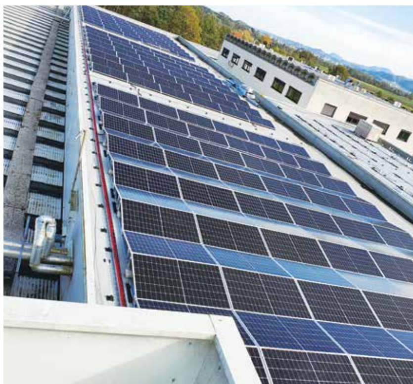
Skoraj 1000 modulov sončne elektrarne bo nameščenih na delu streh kompleksa Mlekarnice Celeia v Arji vasi.
