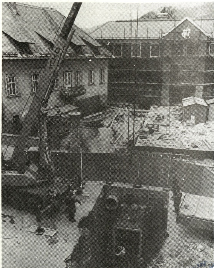
Gradnja centra ter podhoda do upravne stavbe
