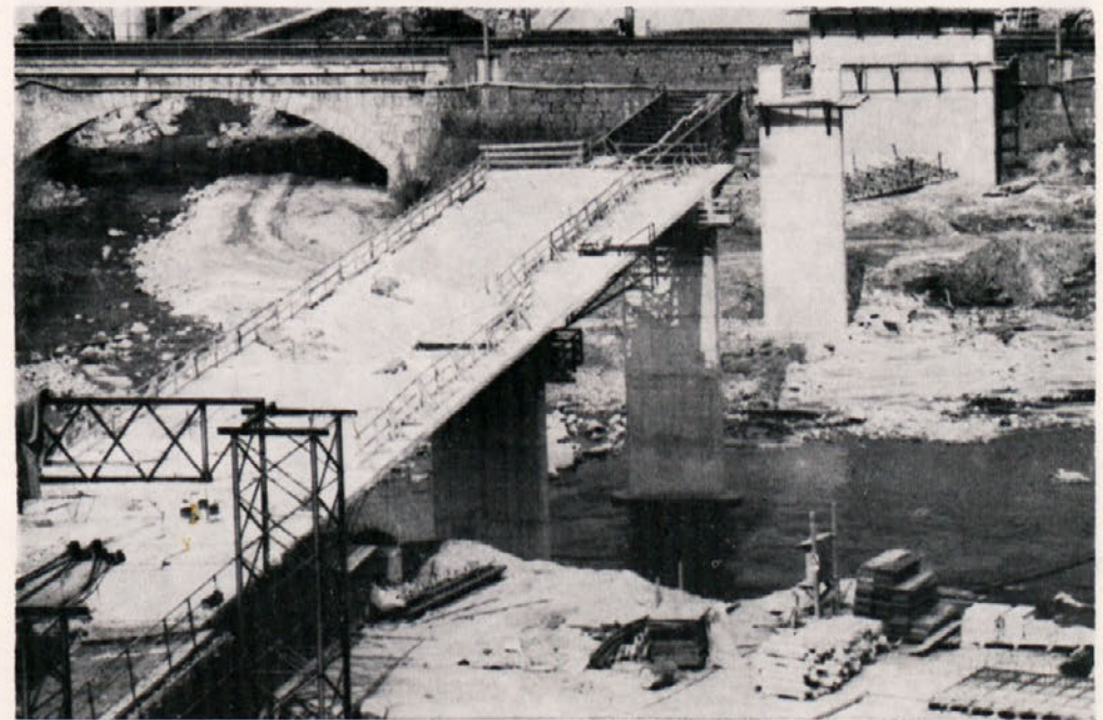
V Zagorju lepo napreduje gradnja mostu čez Savo po novi tehnologiji »s potiskanjem«. Izvajalec del je temeljna organizacija Gradbena operativa Laško.
