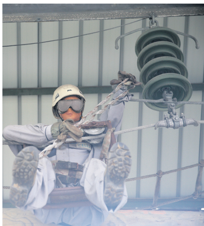
Prikaz terenskega dela na daljnovodnih napravah
