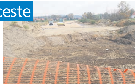
Urejanje nasipov za gradnjo severne vezne ceste (Foto: SHERPA)
