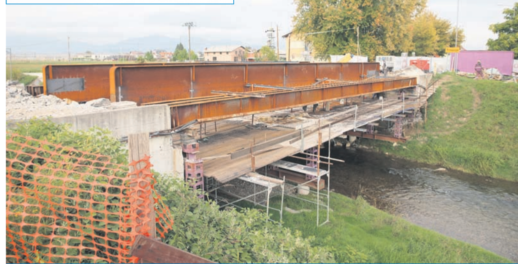
Gradbišče na mostu čez Hudinjo (Foto: GrupA)
