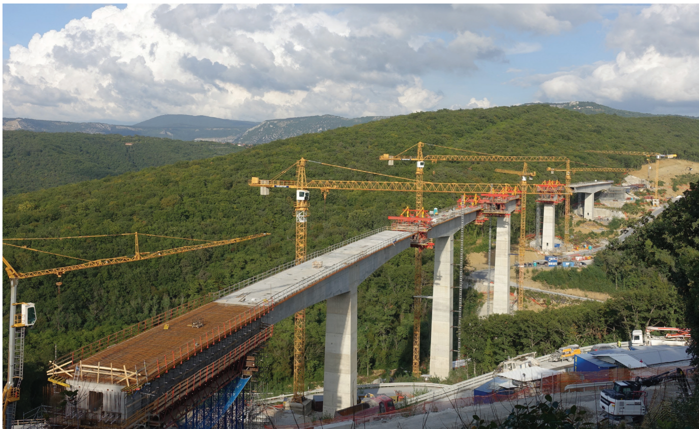
Slika 13. Zgornja plošča v polju na težkem podpornem odru je pripravljena za vgradnjo betona, september 2023.
