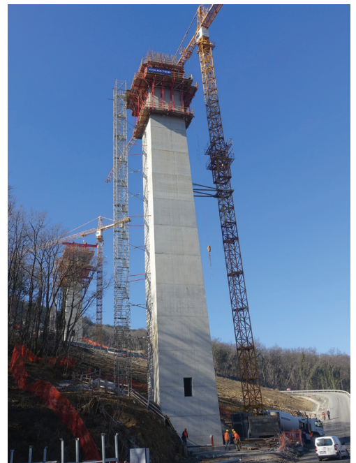
Slika 5. Steber v osi 6 pri višini izgradnje 50 m, februar 2023.
