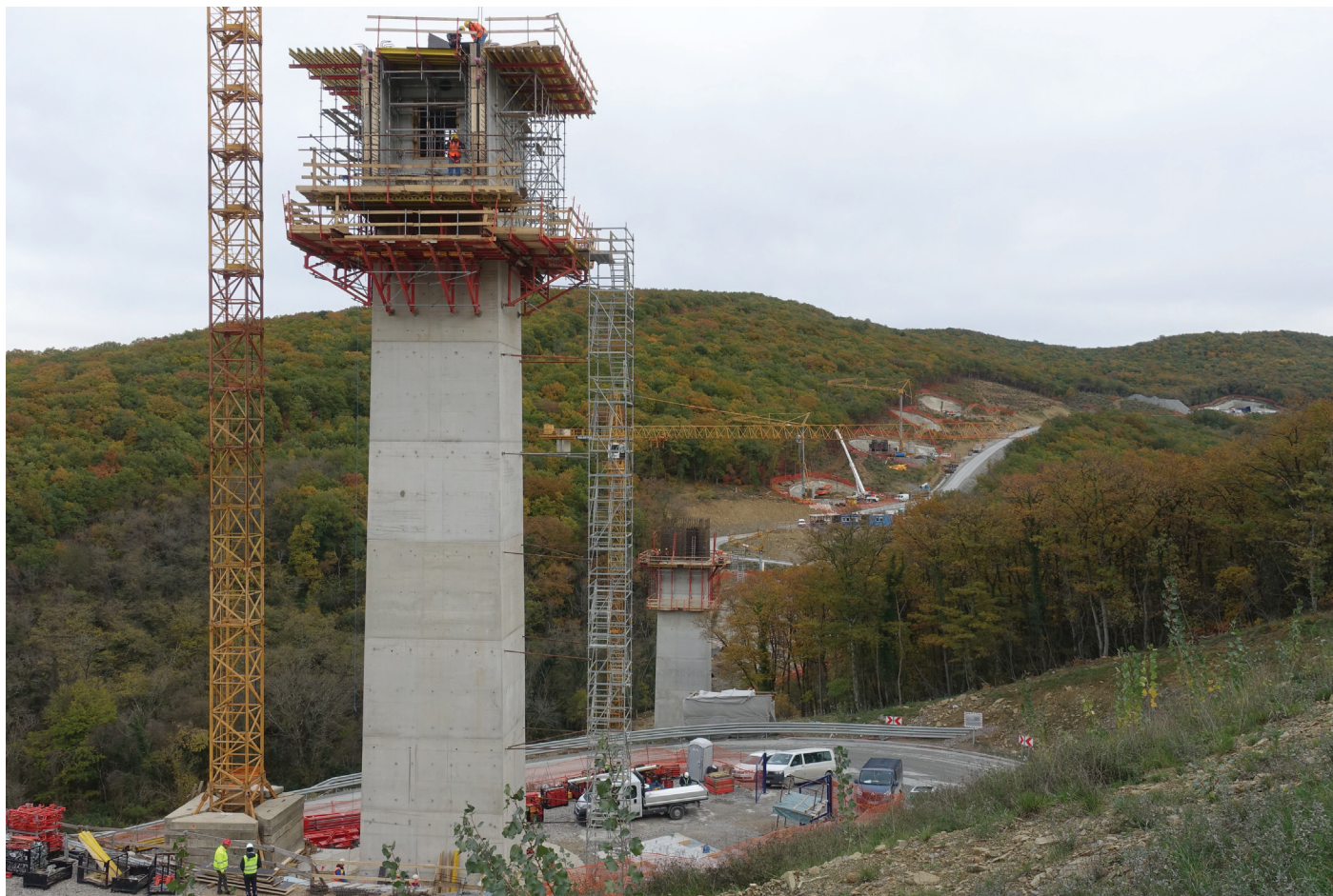
Slika 6. Izdelava baznega segmenta v osi 7, november 2022.
