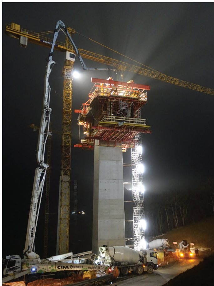
Slika 10. Vgradnja betona se lahko zavleče tudi v noč, februar 2023.
