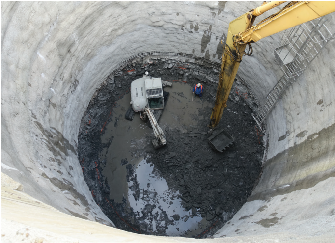
Slika 2. Izkop vodnjaka globine 16 m, zaščitene s cementnim obrizgom, november 2022.
