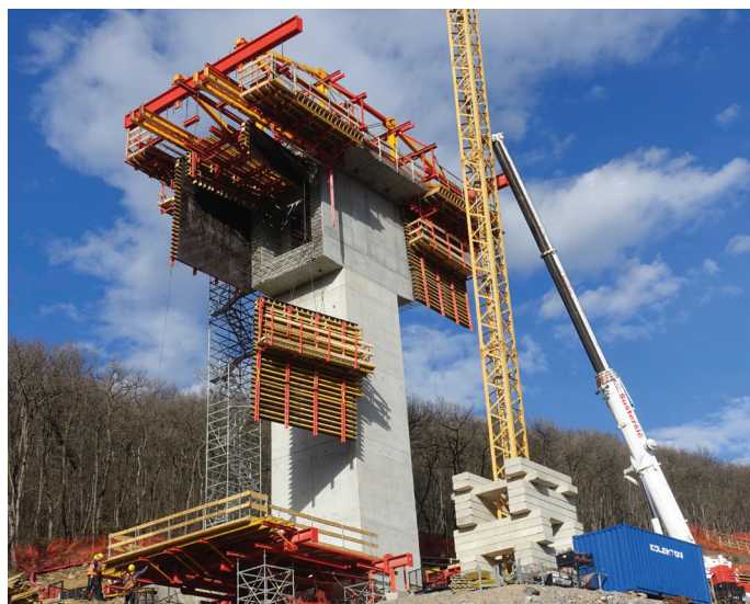
Slika 8. Montaža opažev PKG v osi 3, marec 2023.
