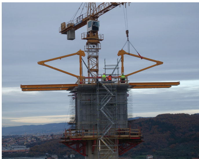
Slika 7. Montaža nosilnih konzol vozička v osi 7, december 2022.
