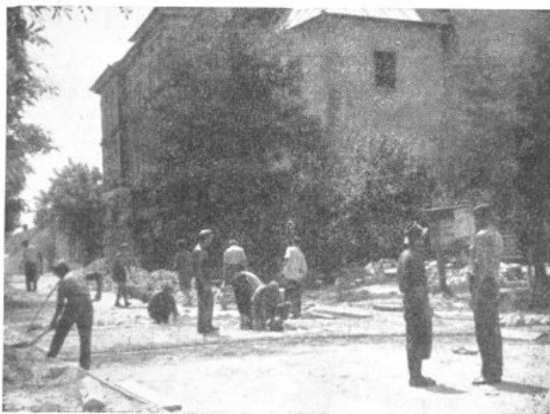
MAGISTRALA SKOZI LENART KONČANA. — Pred dnevi so delavci Cestnega podjetja Maribor položili zadnje metre kock in tlaka na odseku severne magistrale
